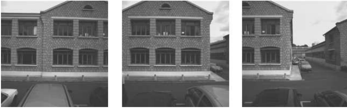
Figure 1: Exemple d'images de façades (210 209 208)
